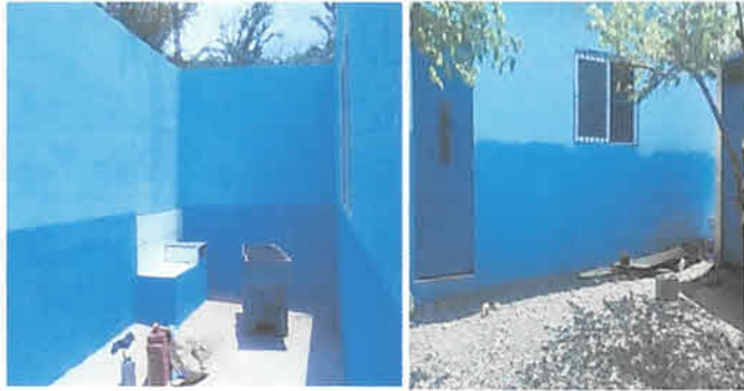
Foto 1: Finalización de ampliación de cocina.
