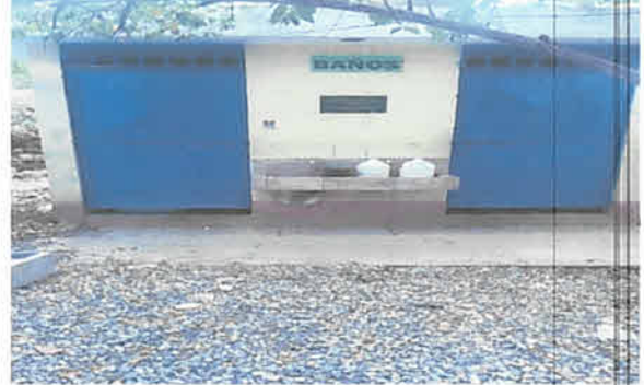
Foto 2: Cambio de pintura de puertas de baño.
