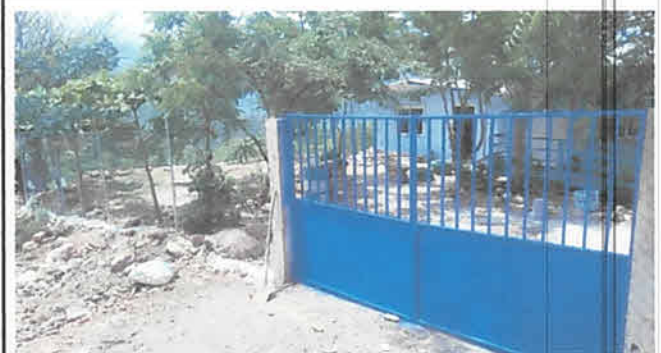
Foto 4: Cambio de portón.
